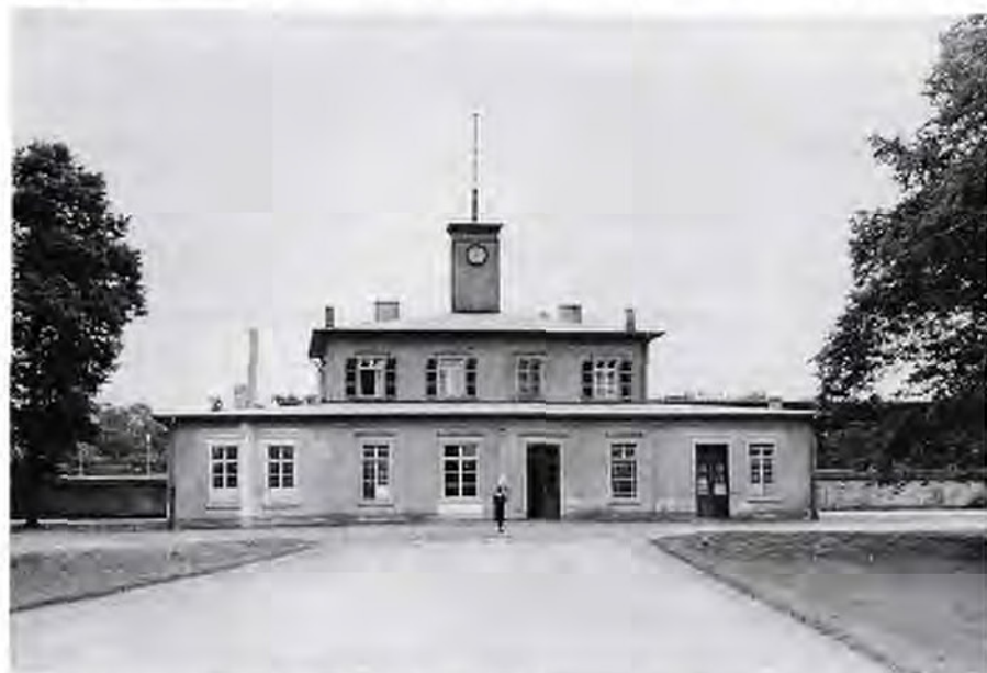
Bundesbahnhof Brühl im ursprünglichen Zustand.
